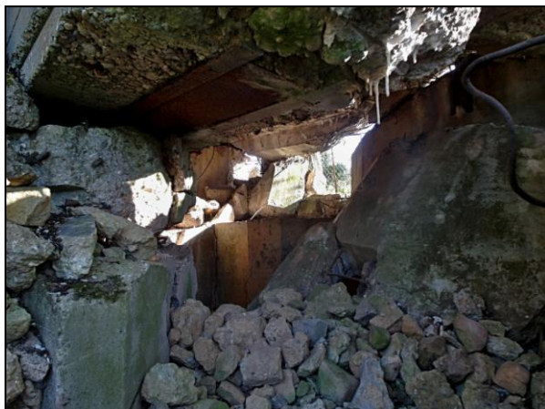
▲ [5024230] Im angehängten Kampfraum: Blick vom Eingang über die umgefallene Splitterschutzwand hinweg auf die MG-Scharte in der Frontwand. (Bild: © WWMP 21.06.15)
