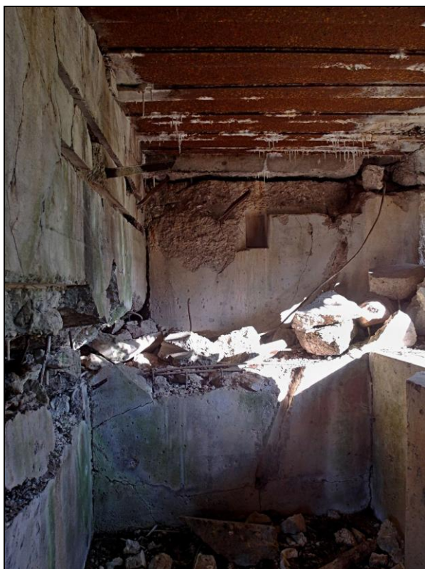
▲ [5024232] Im angehängten Kampfraum: Die Trennwand mit dem Unterstand. (Bild: © WWMP 21.06.15)
