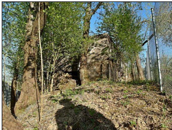
▲ [5024227] Ansicht von Nordwesten auf die rechte frontseitige Bauwerksecke des angehängten Kampfraumes. (Bild: © WWMP 21.06.15)
