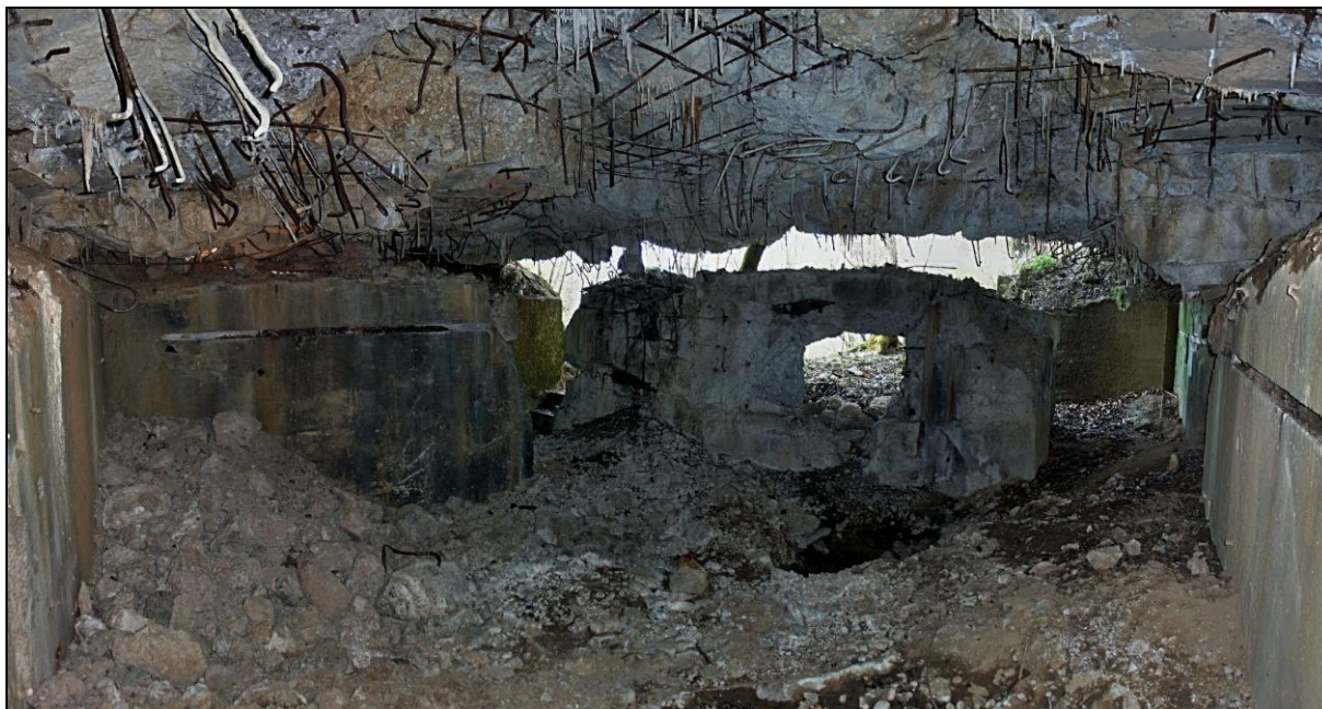
▲ [5024228] Blick vom Bereitschaftsraum auf die Innenseite der Hofwand mit der MG-Scharte zwischen beiden Gasschleusen. (Bild: © WWMP 21.06.15)
